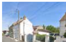
Centre-bourg de Bois-le-Roi – Rue de la République
