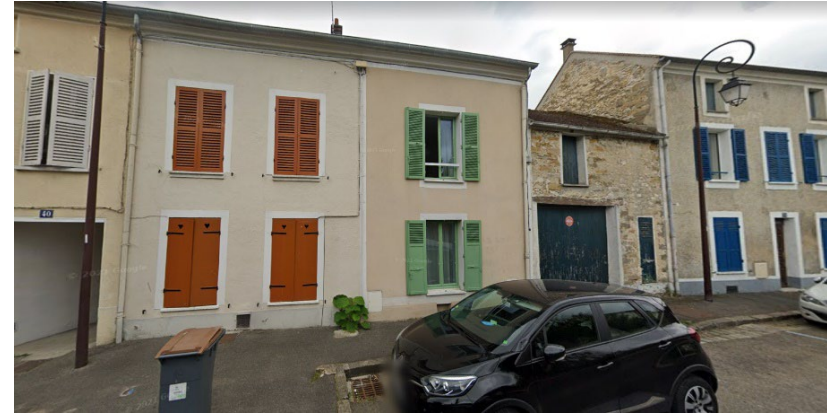
Alignement d'anciennes maison rurales, rue de la République à Avon : la densité et la modestie du bâti ainsi que le maintien de certains marqueurs (porte charretière surmontée de sa fenêtre gerbière) participent à la préservation d'une ambiance rurale en cœur d'agglomération.
