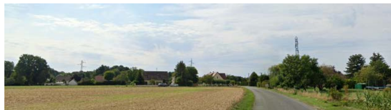
PYLÔNES ÉLECTRIQUES DE LA LIGNE 150kV EN PROVENANCE DU CHATELET-EN-BRIE À HÉRICY – SOURCE : STREET VIEW
