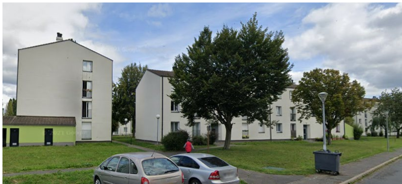
VUE DES IMMEUBLES DE L'ALLÉE DES ROSES COMPOSANT L'ENSEMBLE MIXTE DE LOGEMENTS COLLECTIFS ET D'ÉQUIPEMENTS DE LA CHAPELLE-LA-REINE.
