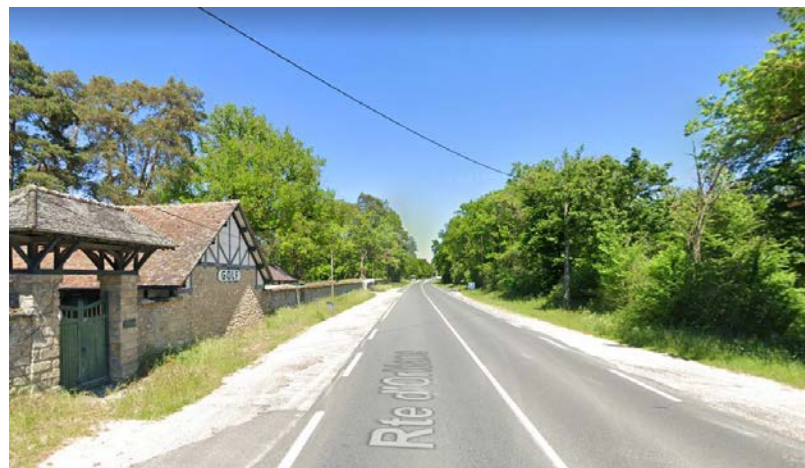
PHOTOGRAPHIE 500 MÈTRES EN AMONT DU ROND-POINT DE L'OBÉLISQUE (ROUTE D'ORLÉANS) (GOOGLE MAPS)
