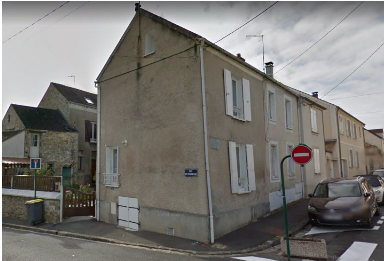
Ilot de constructions traditionnelles à l'angle des rues des Provençaux et Pierre-Charles-Comte à Fontainebleau : sur le front de rue, les façades ont été régularisées (emplacement et percement des baies, corniche, enduit épais...) tandis que sur le pignon et à l'arrière les caractéristiques traditionnelles s'affichent nettement (matériaux locaux, percement aléatoire...).
