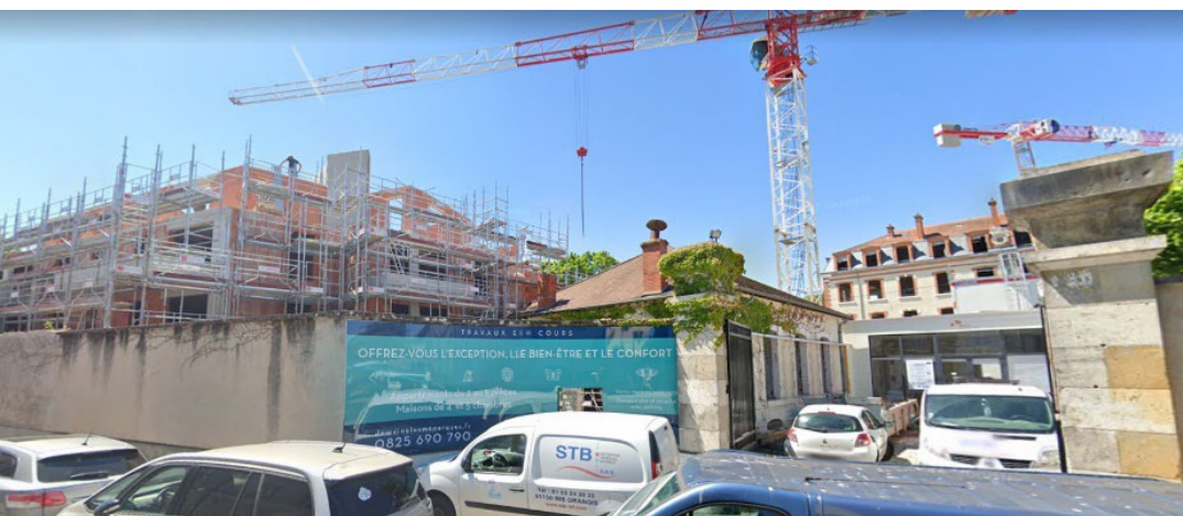
L'OPÉRATION EN COURS DE LA CASERNE CHATAUX À FONTAINEBLEAU (115 LOGEMENTS)
