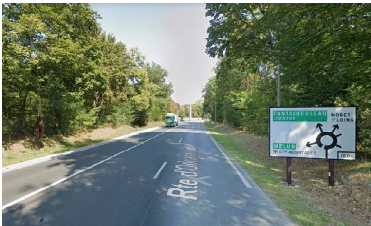
PHOTOGRAPHIE 100 MÈTRES EN AMONT DU ROND-POINT DE L'OBÉLISQUE (RD152) (GOOGLE MAPS)
